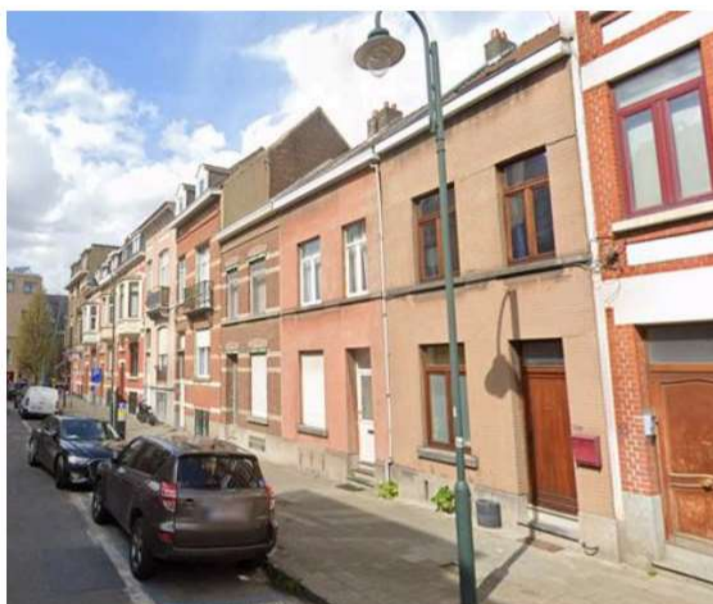
Figuur 11: Stedelijk weefsel - traditionele Brusselse bebouwing (bron: Google Street View)
